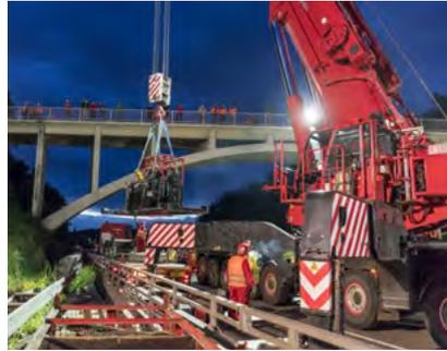
**DER TEREX SETZT** sich zuerst die Ballastgrundplatte mit Winde auf, dann folgen die Stahlgewichte (l.).
