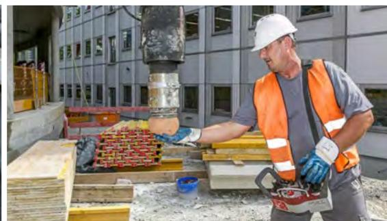
**NACH DER BETONAGE** ist vor der Betonage, darum gehört das Reinigen der Schläuche auch zum Job (o.).
