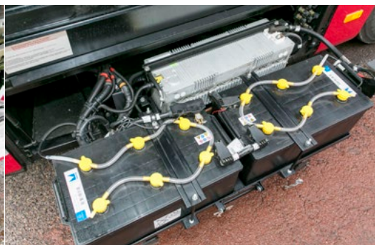
Hinter den Batterien sammeln Supercaps als sogenanntes Rekuperationsmodul Strom.
