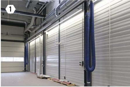
**1** Abgetrennt vom Rest der Servicebahnen befindet sich ein Raum für Arbeiten an Brennstoffzellen-Lkw. Sensoren an der Wand schnüffeln nach Wasserstoff. Bei Gefahr kann sofort entlüftet werden.
